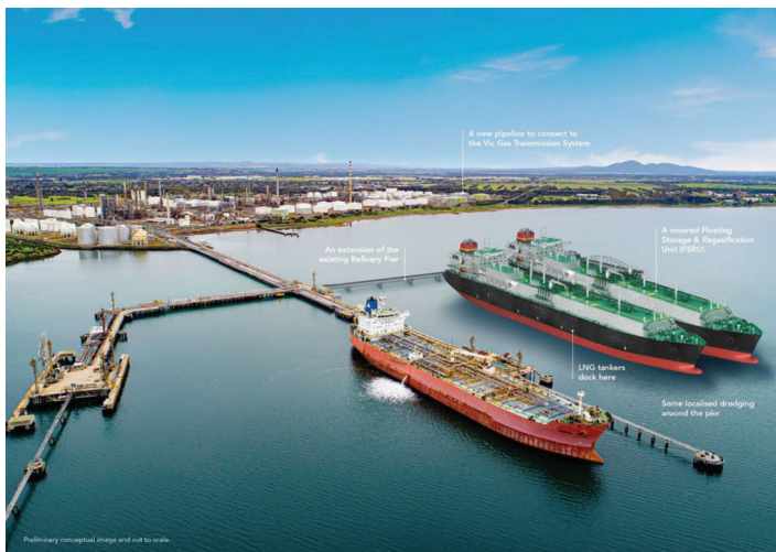
Geelong's LNG terminal project moves ahead
