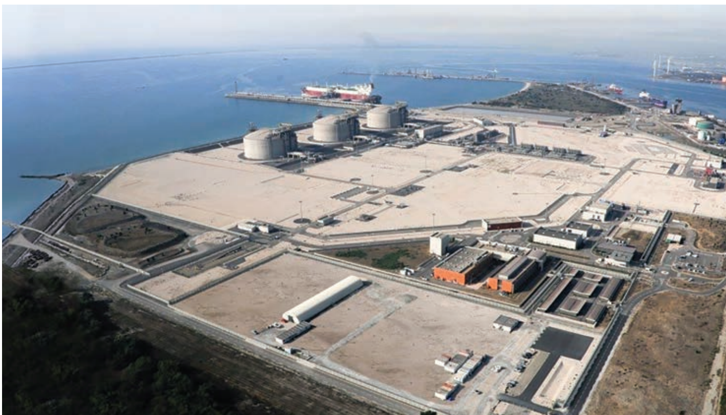
Fos Cavaou LNG terminal
