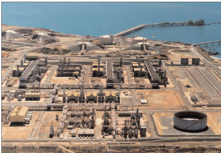
The North West Shelf's LNG export terminal
