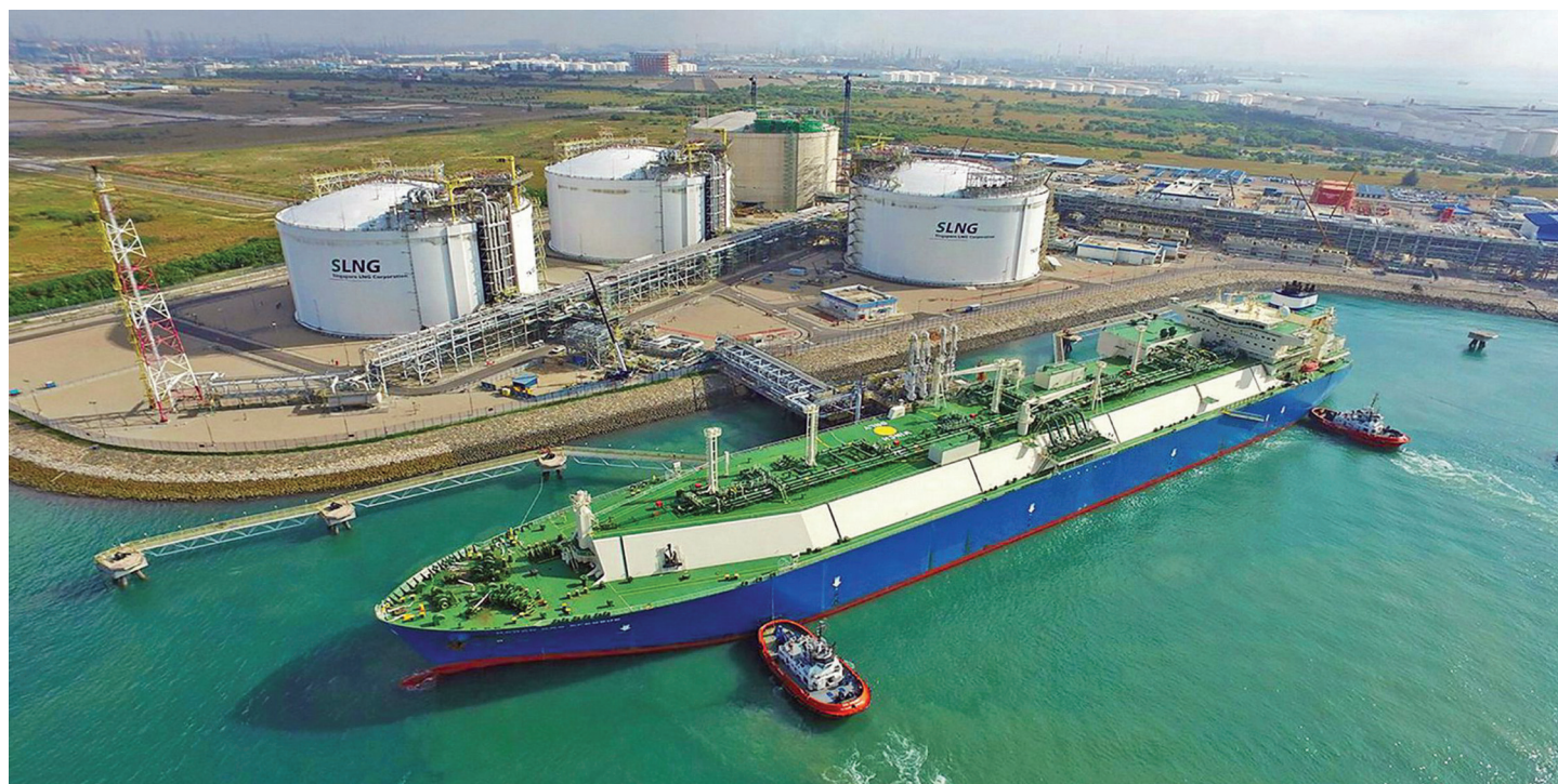
Singapore LNG terminal
