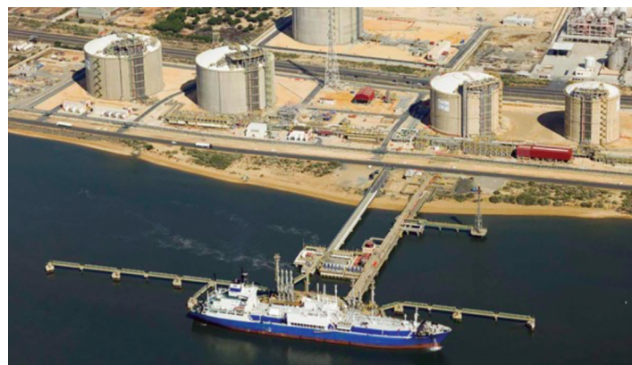
The Enagás Huelva LNG terminal in southwest Spain
