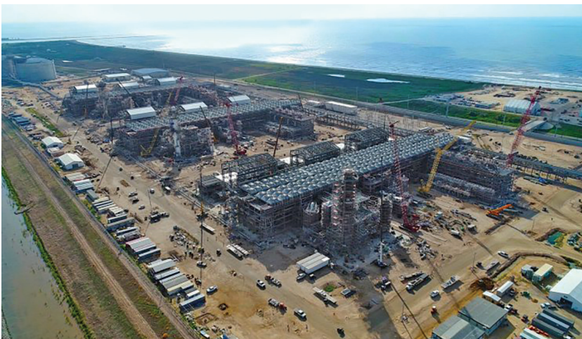
Construction works forge ahead on Freeport LNG Train 1-3
