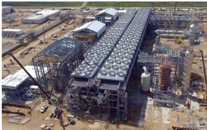
Construction works at Freeport LNG Train 1
