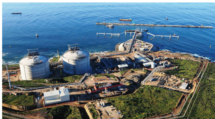
Costa Azul LNG terminal, Mexico
