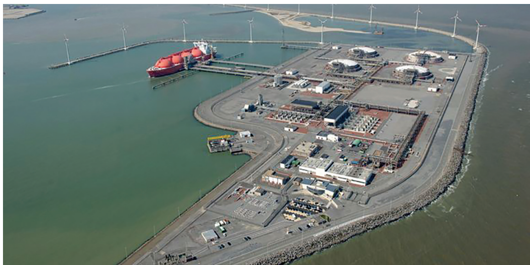
Fluxys LNG terminal
