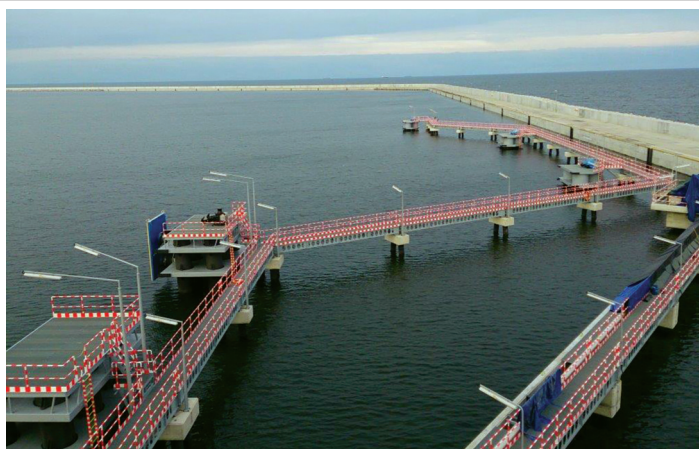
Świnoujście sea wall
