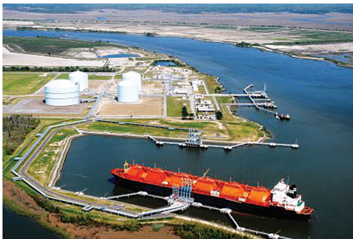
Elba Island LNG in Savannah, Georgia
