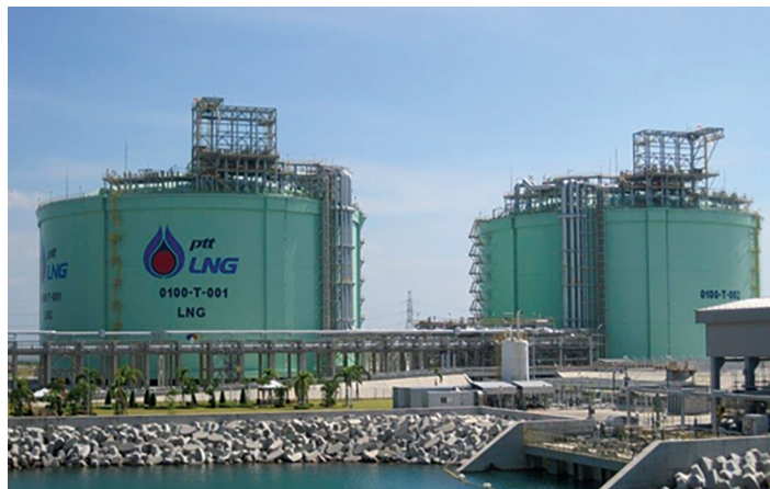
LNG terminal at Map Ta Phut in Rayong province
