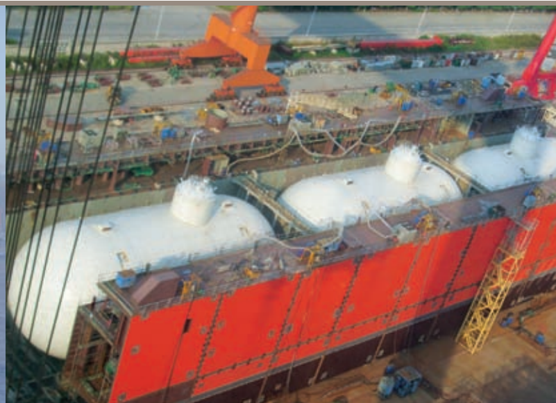
LNG type C cargo tanks for LNG-FLSRU
