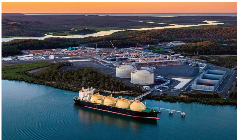
Queensland Curtis LNG terminal
