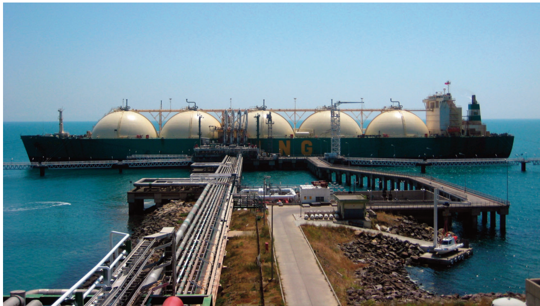
BOTAS' Marmara Ereğlisi LNG terminal
