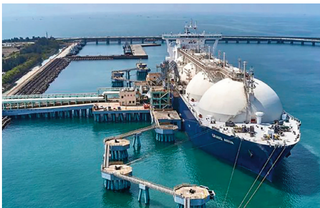
CPC's second LNG terminal in Kaohsiung, Taiwan
