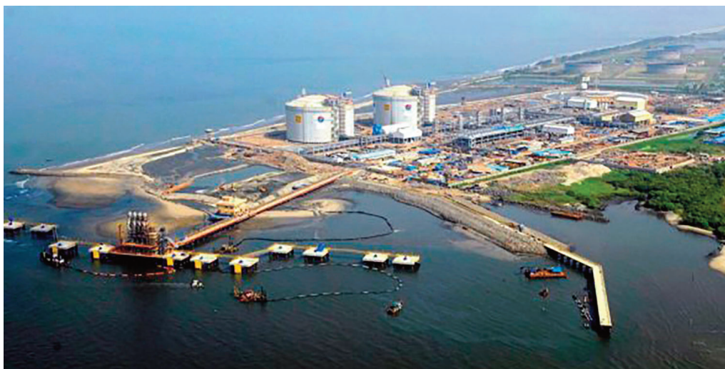
Petronet's Kochi LNG terminal
