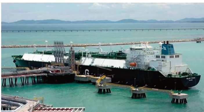
Map Ta Phut LNG terminal in Thailand
