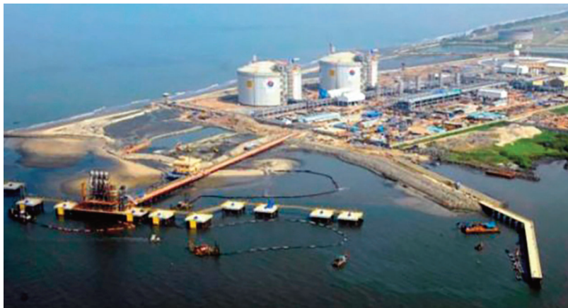
Chhara LNG terminal in India
