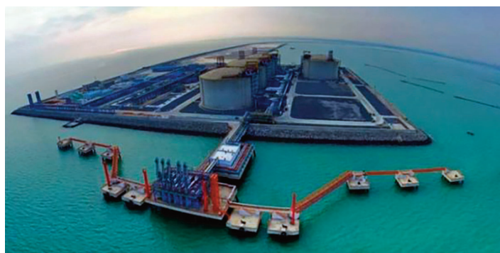
LNG terminal in Pakistan
