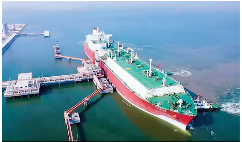
LNG carrier berthing at GAIL's Dabhol regas terminal
