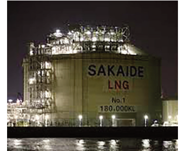
JERA's Sakaide LNG import terminal
