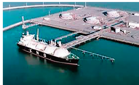
LNG arm of ADNOC's Das Island
