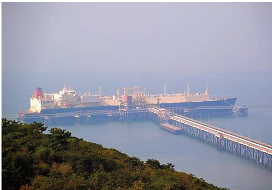
LNG carrier berthing at GAIL's Dabhol regas terminal
