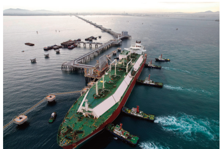
PTT's Nong Fab LNG terminal. Source: Saipem
