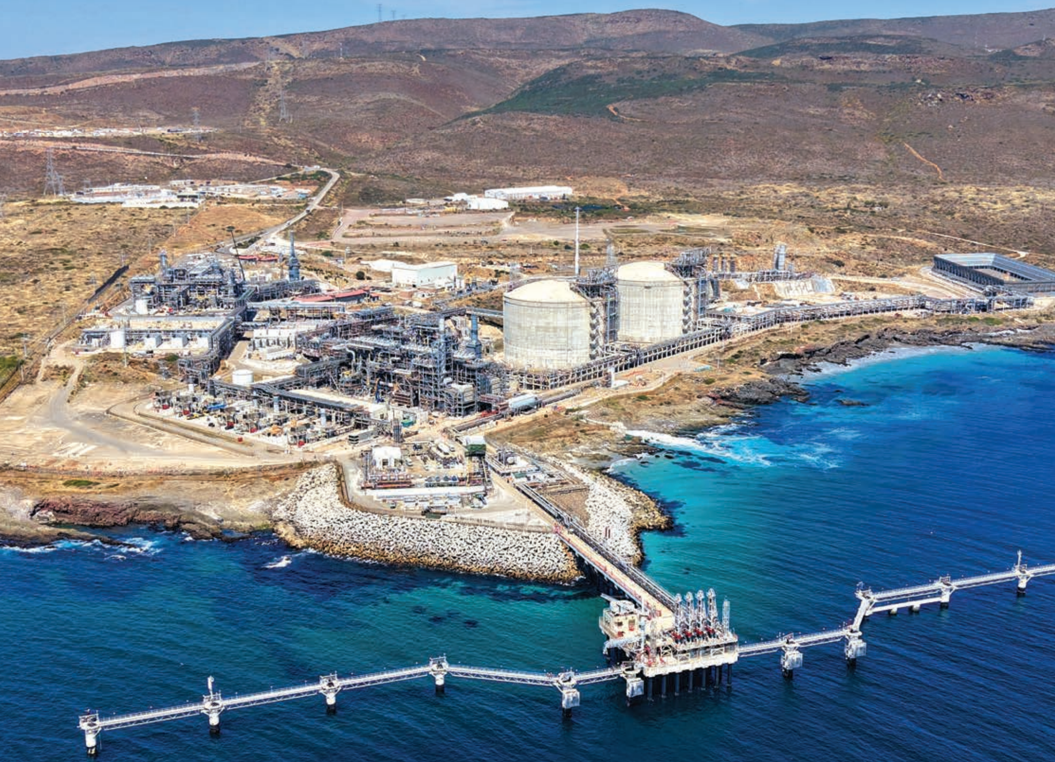
ECA LNG, Baja California
