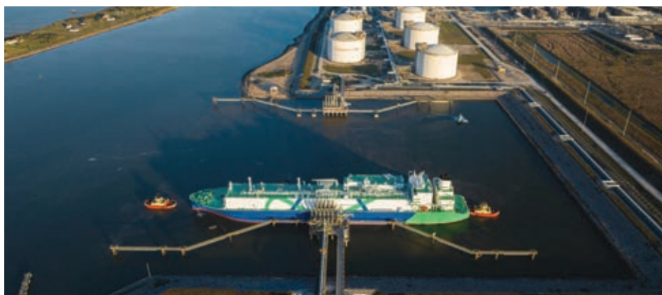
Birds eye view of Golden Pass LNG terminal
