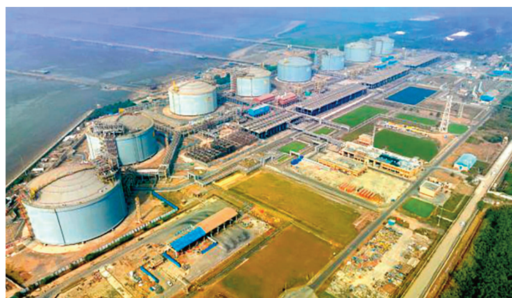
Petronet's Dahej LNG terminal
