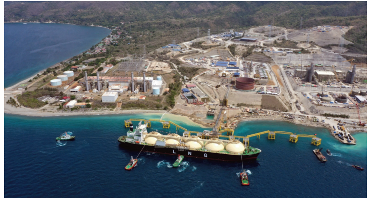
AGP's Philippines LNG terminal
