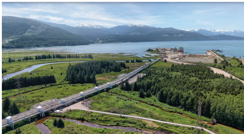
LNG Canada's Kitimat site
