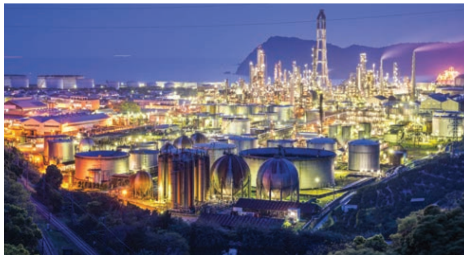
Gwangyang LNG Terminal
