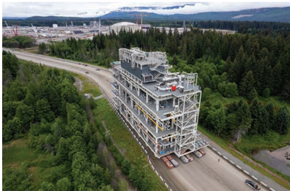
Module delivery to the LNG Canada site in Kitimat
