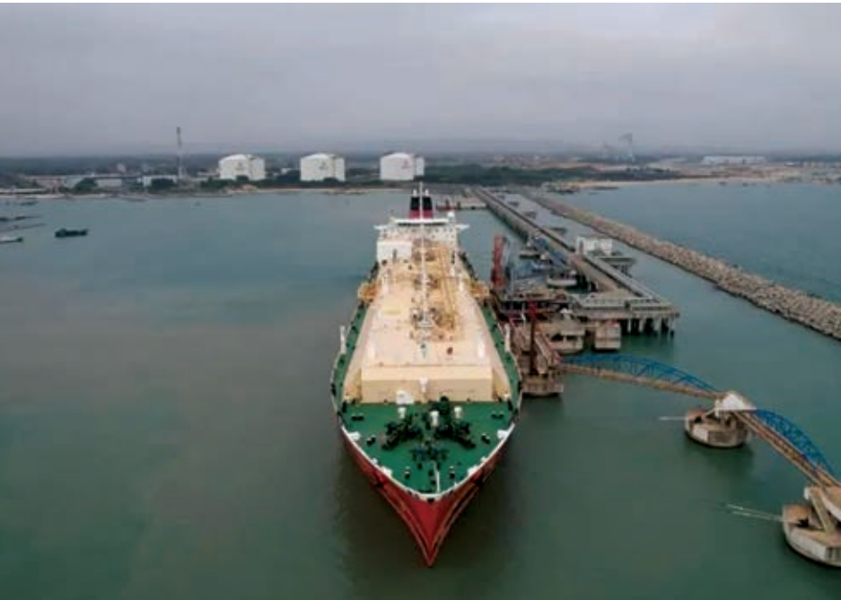
PipeChina’s Yuedong LNG terminal in Huilai County, Guangdong
