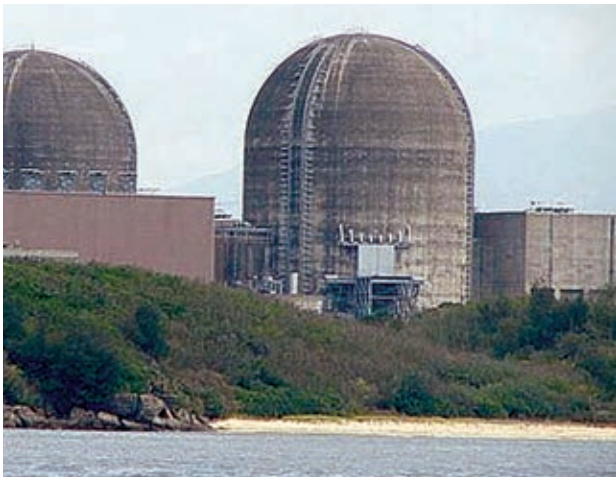
Maanshan nuclear power plant
