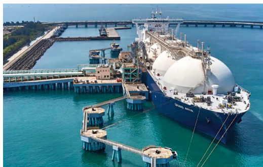
CPC's second LNG terminal in Kaohsiung, Taiwan
