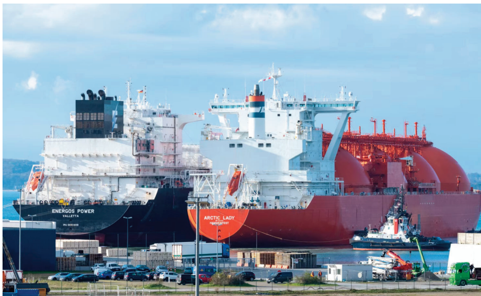
LNG regas terminal at Mukran, Germany
