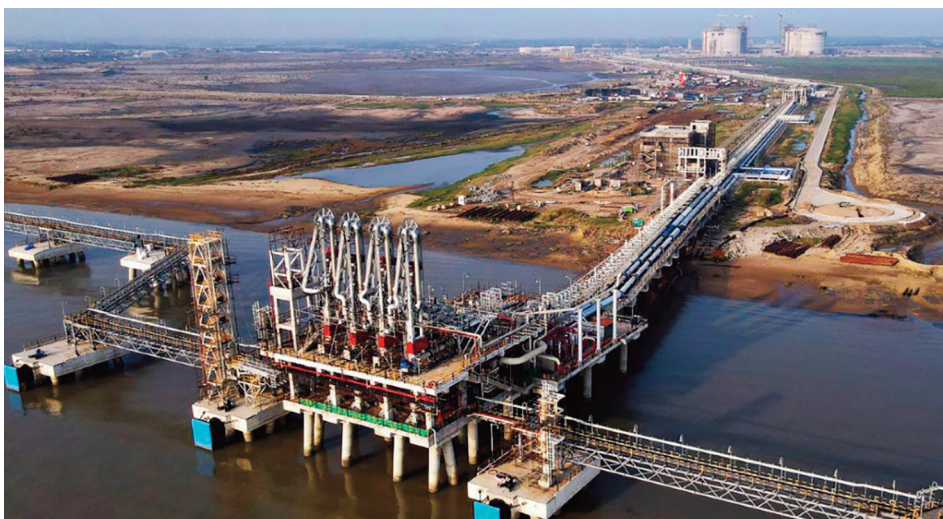
Adani Total's Dharam LNG terminal
