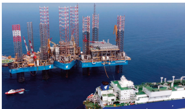
NFE's Altamira Fast LNG terminal
