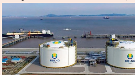
China onshore LNG tank
