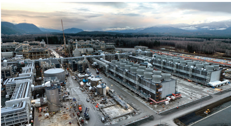
Construction at LNG Canada terminal, Kitimat
