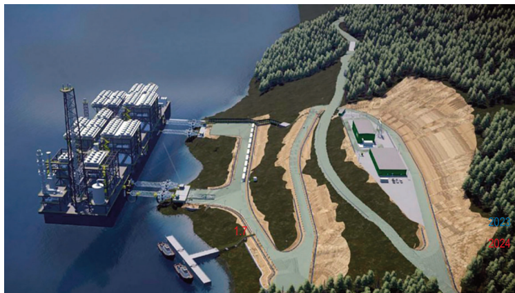
Render of the Cedar LNG project in Kitimat
