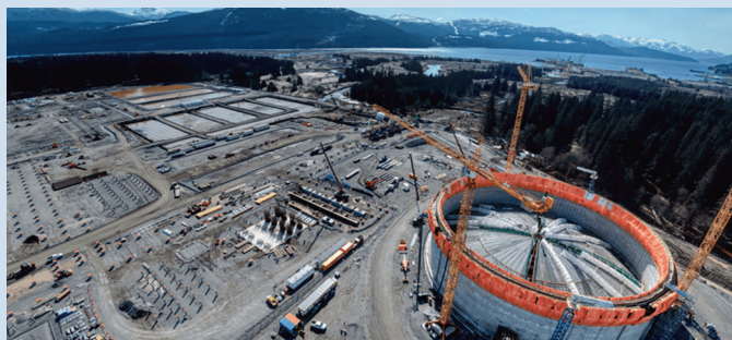
Construction on LNG Canada in Kitimat, BC
