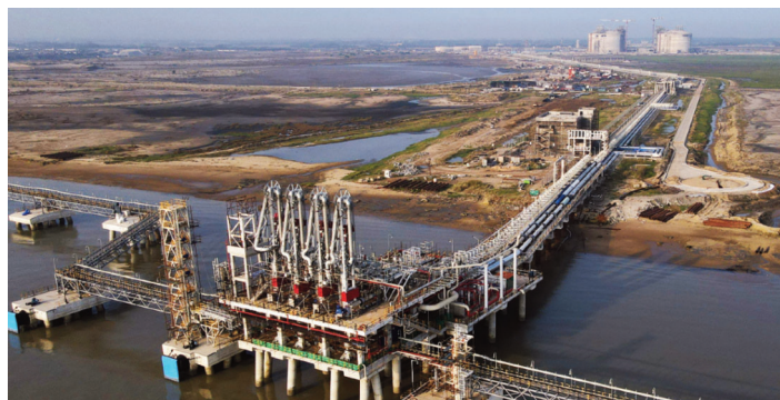
India's Dhamra LNG import terminal in Odisha state
