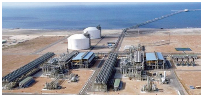
Egypt's Idku LNG terminal sited east of Alexandria
