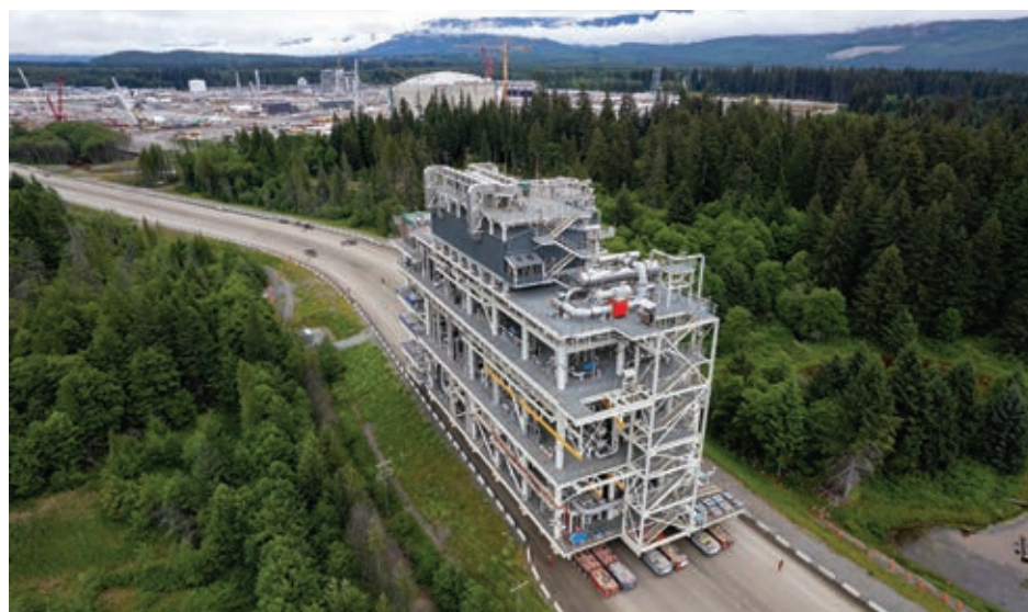
Module delivery to LNG Canada site in Kitimat
