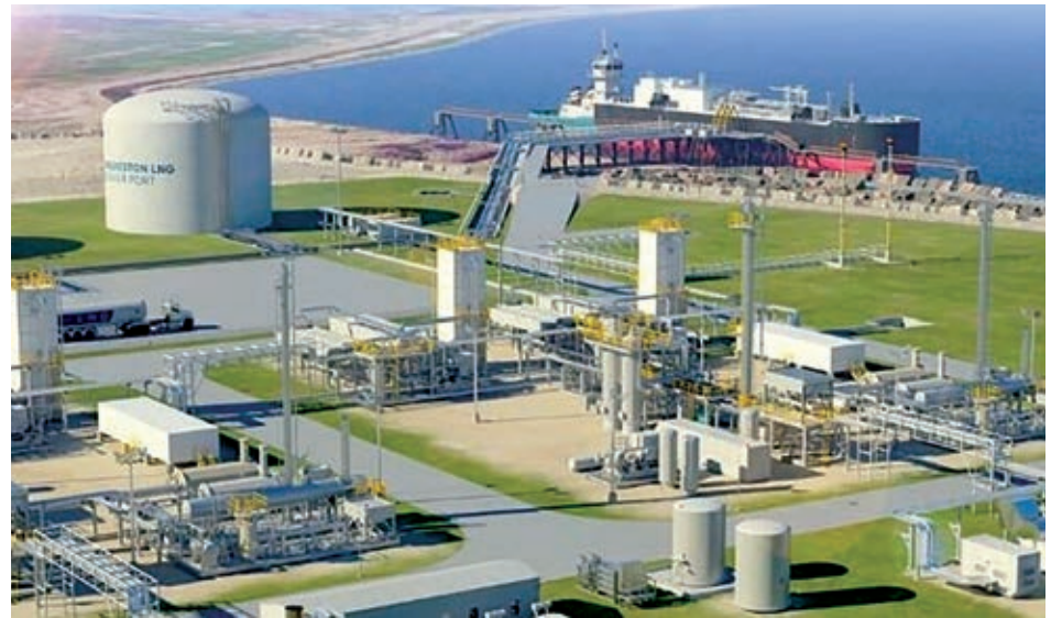
Galveston LNG bunker terminal
