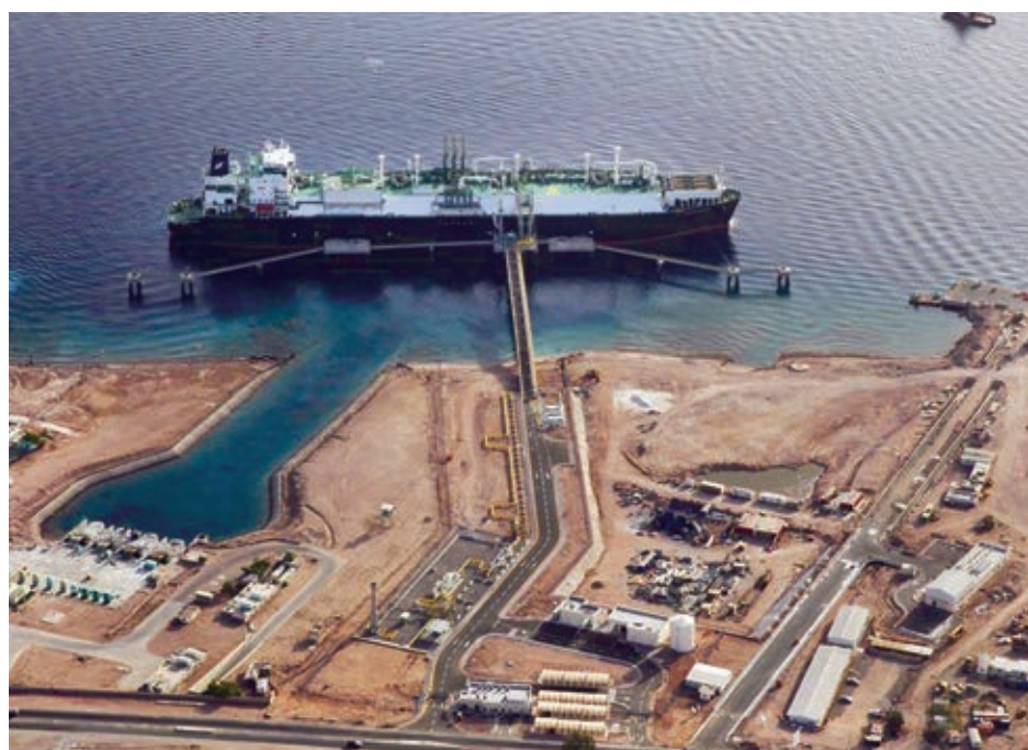
Jordan's Aquba LNG regas terminal
