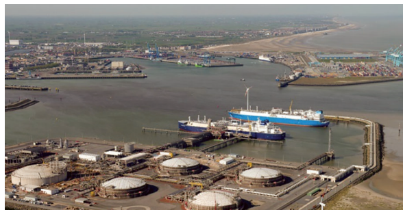
Fluxys' Zeebrugge LNG terminal
