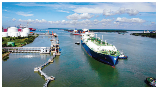
PetroVietnam's Thi Vai LNG terminal
