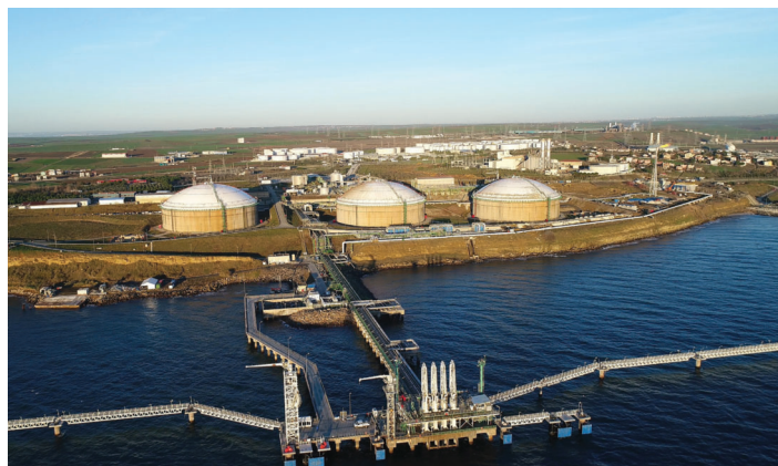
BOTAS' Marmara Ereğlisi LNG terminal
