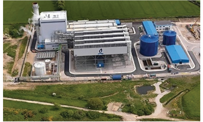
Bord Gáis Whitegate power station
