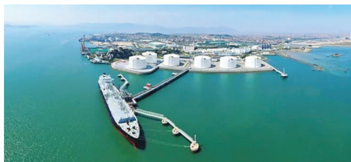
CNOOC's Fujian LNG terminal
