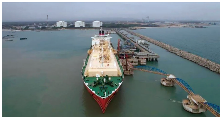
PipeChina's Yuedong LNG terminal
