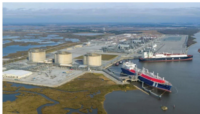
Cameron LNG in Hackberry, Louisiana
