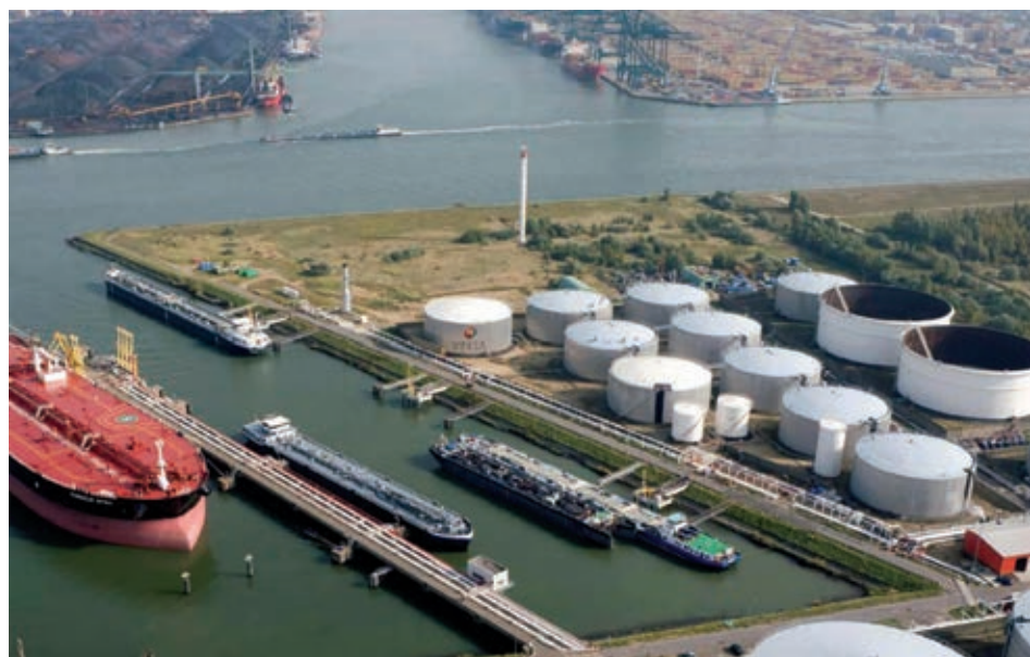
LNG bunkering at the Port of Rotterdam
