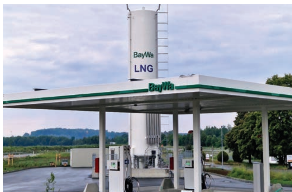
BayWa LNG fuelling station
