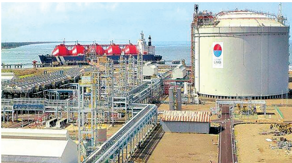
Petronet's Dahej LNG terminal
